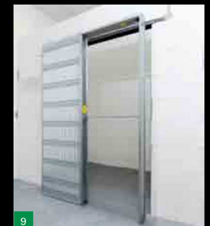
Sestavené pouzdro připravené k osazení do stavebního otvoru
