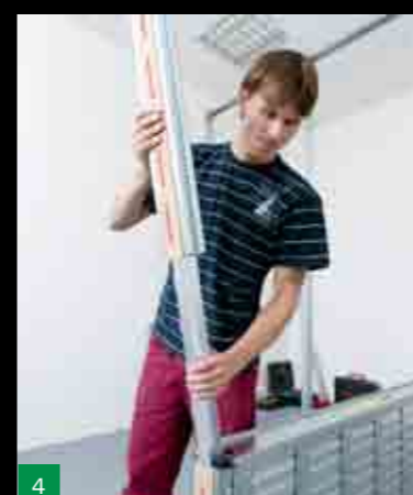
4 Vložte kolejnici s nadpražím do horní části pouzdra
