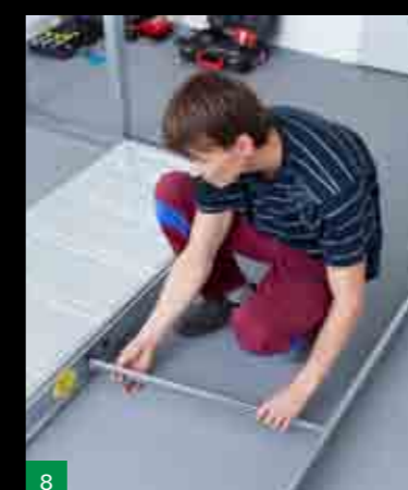
8 Ohnuté distanční vzpěry zasunout do prolisů
