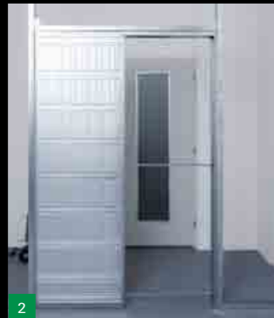
Usazení pouzdra do spodního profilu SDK
