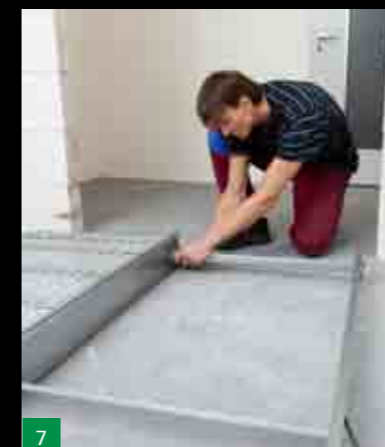
Ohnuté distanční vzpěry zasunout do prolisů
