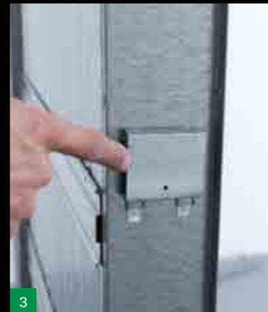
Kotevní místo pro SDK profil stavebního pouzdra
