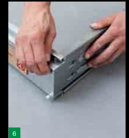
Ohněte jazýčky stojiny, aby došlo k zajištění
