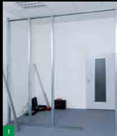
Příprava profilů SDK pro usazení pouzdra
