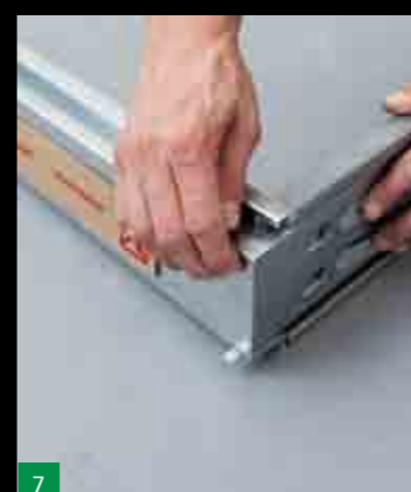
7 Ohněte jazýčky stojiny, aby došlo k zajištění
