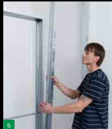
Montáž protilehlé strany SDK konstrukce
