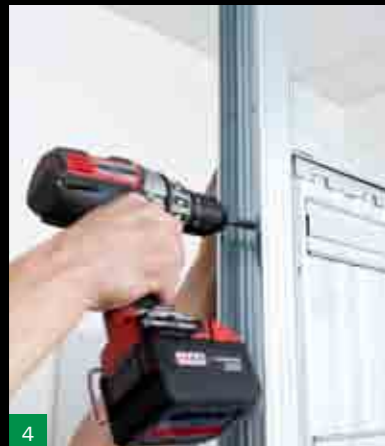
Připevnění pouzdra ke konstrukci SDK
