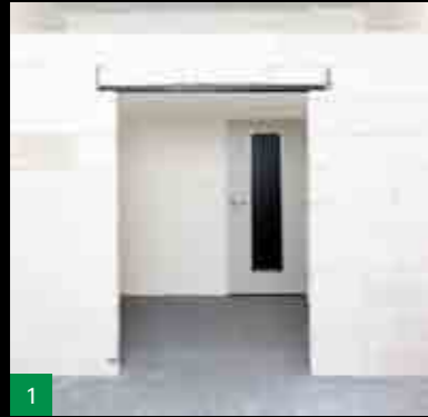
Připravený stavební otvor
